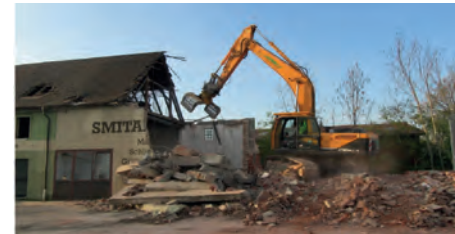
Abbruch- und Baggerarbeiten
